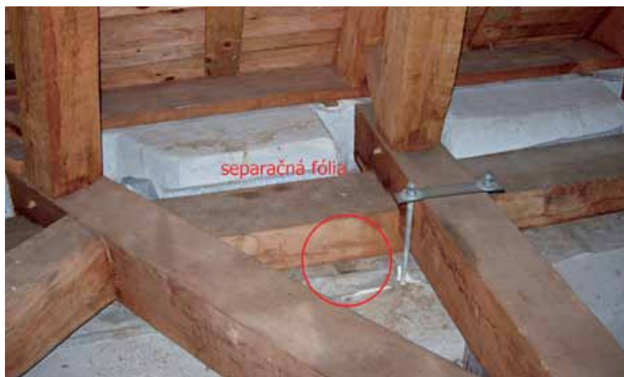
Obr. 8 Uloženie pomúrnic na fólii a na dubových podložkách
