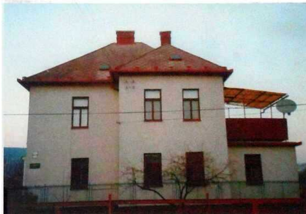
Faršká budova pred rekonštrukciou
