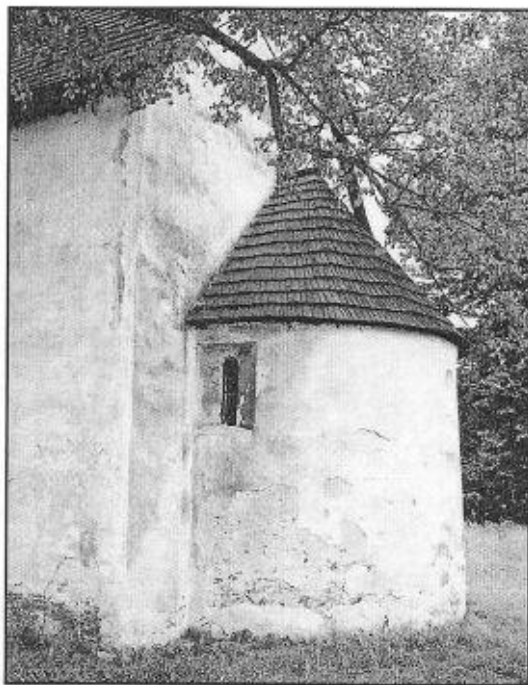
Pohľad na apsidu
